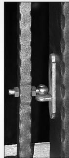
ピンヒンジは最もシンプルで目立たないヒンジで、適合するオス・メスのパーツを組合せて、回転の必要な箇所に幅広く使われています。摺動部分には市販のステンレスワッシャを挟んで使用します。メス側にデンデンボルトを使うと、門柱と扉の間隔やある程度の傾きを現場調整できます。
