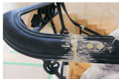
継目の隙間やネジ頭をポリパテ仕上した後、本体と同色でタッチアップ塗装して完了です。
