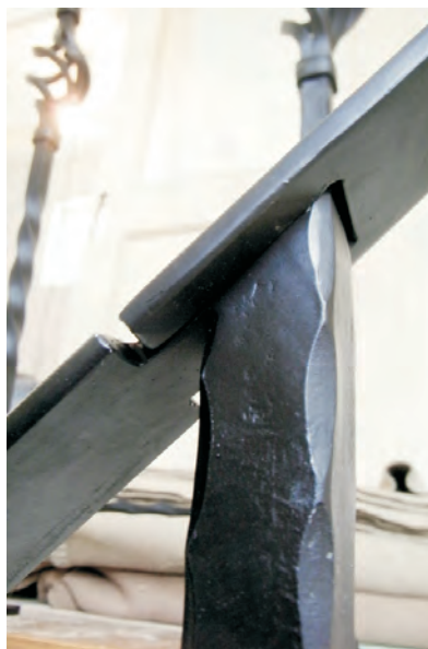
継目の隙間やネジ頭をポリパテ仕上した後、本体と同色でタッチアップ塗装して完了です。
